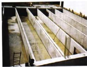
Kanali za skladištenje gnojovke ispod staje („stalom sistem“)
